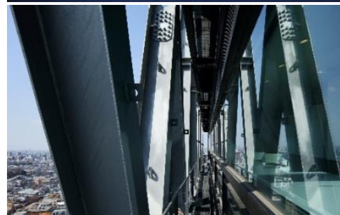
水平基調で柱が少ないオフィス空間
